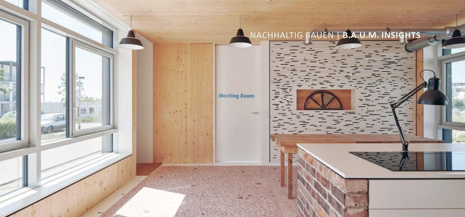
Das Recyclinghaus Hannover verwendet gebrauchte Bauteile und Recyclingbaustoffe wie Holz und Metall.
